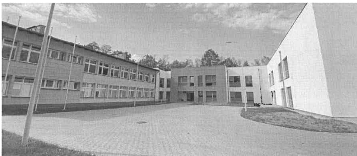
Przebudowa Szkoły Podstawowej w Starej Wsi (źródło: https://www.przekladotwocki.pl/ )
